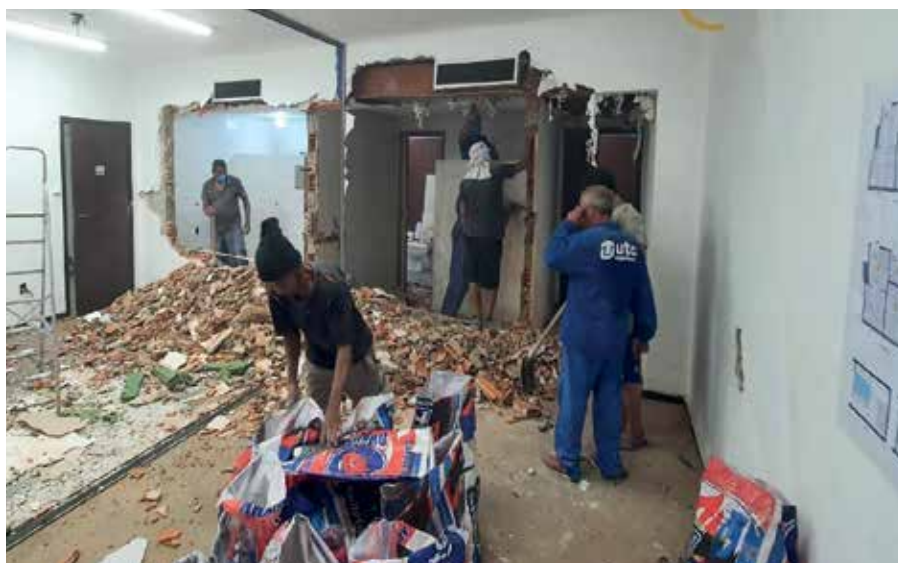
Projeto na parede-equipe trabalhando
