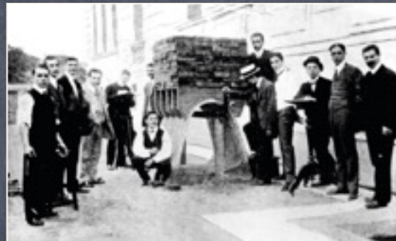
1910: primeiro duto em concreto
